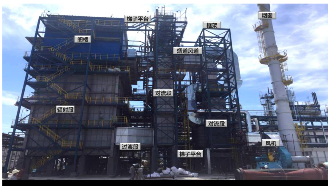
制氢转化炉安装示意图
