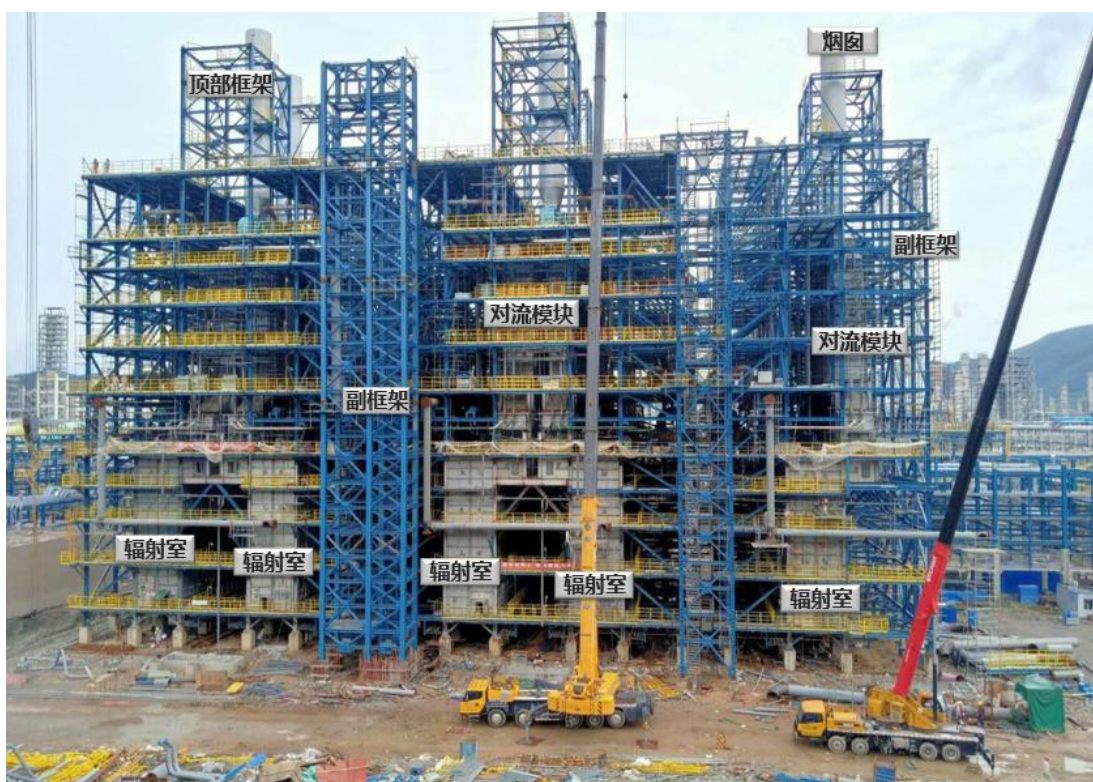
乙烯裂解炉安装示意图
