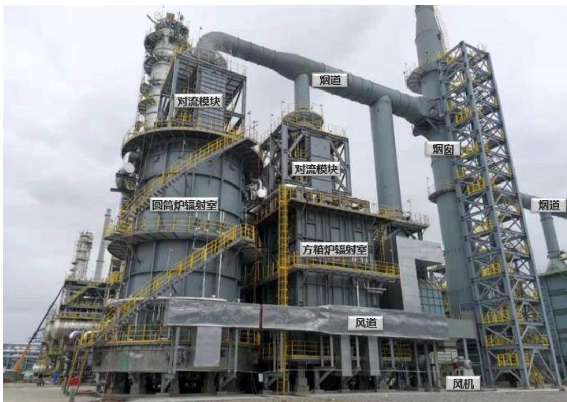
加热炉安装示意图
